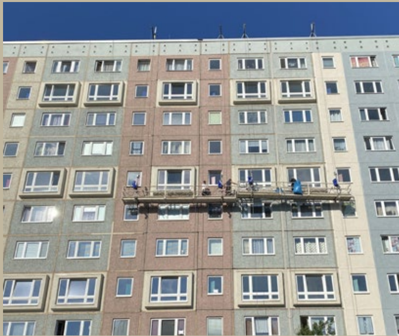
Unsere Bilder dokumentieren die Bearbeitung der Fassaden- und Fugenschäden am Juri-Gagarin-Ring 18, die im vergangenen Jahr ausgeführt wurden.
